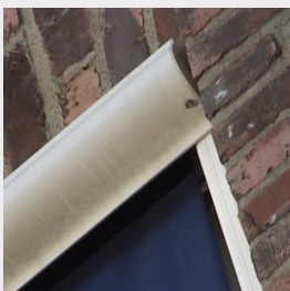
MT74 har en kassett i strängpressat aluminium
