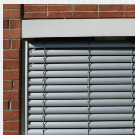
President monterad på utsidan av fönsterkarmen
